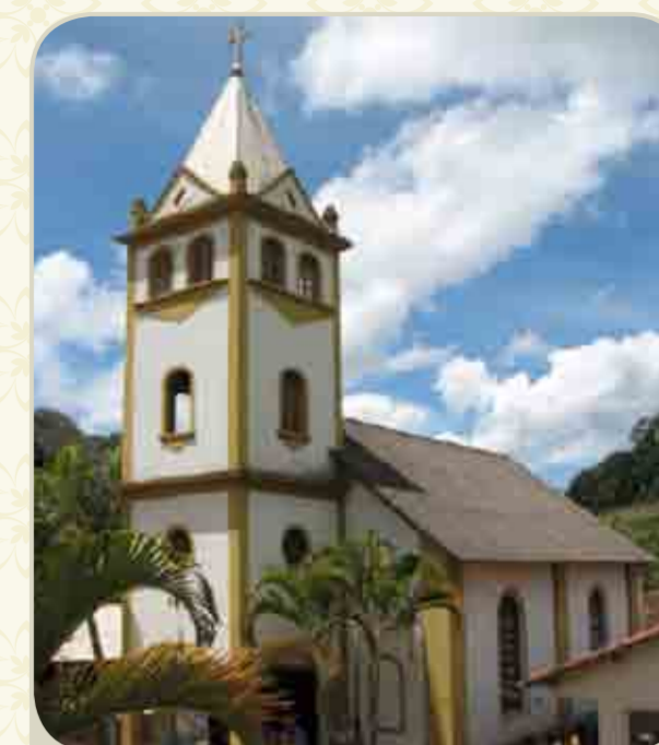
Comunidade São Bento do Chapéu Inauguração: 28.01.1962
