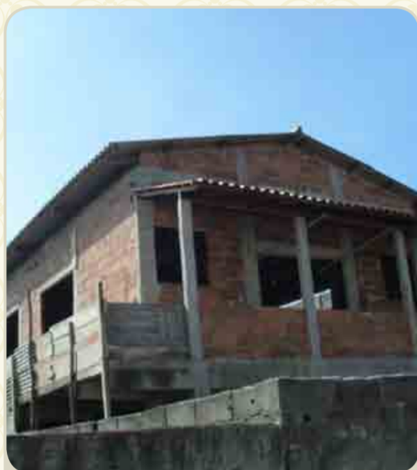
Comunidade Feu Rosa Em construção
