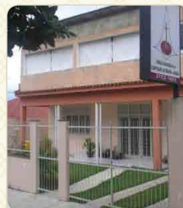
Comunidade Nova Venécia Construção do 1º templo: em torno do ano de 1966
