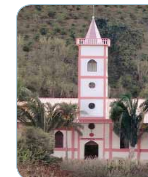
Alto Jatibocas Inauguração: 02/10/1983
